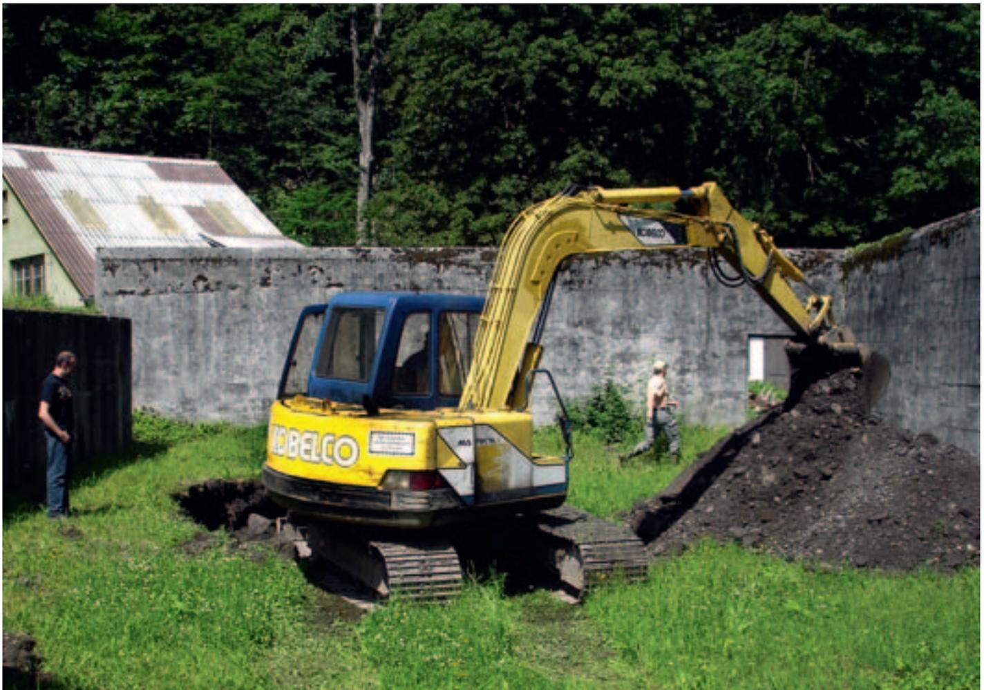
Altlastensanierung auf dem Areal eines ehemaligen Schweizer Sprengstoffherstellers: Mithilfe von Isotopenanalysen lassen sich die Abbauprozesse im Untergrund rekonstruieren.
