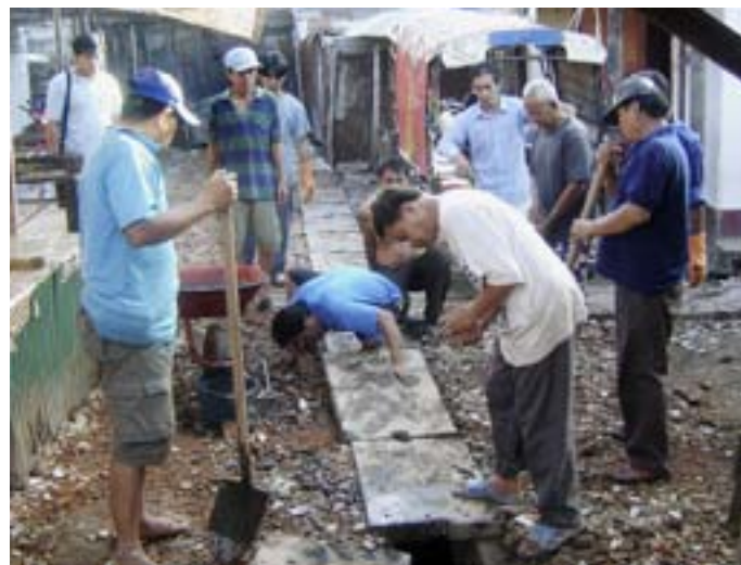
Les habitants de Hatsady Tai, un quartier pauvre de la capitale laotienne Vientiane, travaillent eux-mêmes à la mise en place et à l'entretien de leur système d'assainissement.
