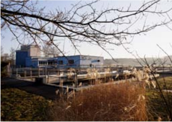
Die ARA Mönchaltorf (ZH) ist Teil des SWIP-Projekts, bei dem gegenwärtig für die Infrastrukturen der Wasserversorgung und Abwasserentsorgung verschiedener Gemeinden ein optimaler Planungsprozess festgelegt und eine konkrete Massnahmenplanung erarbeitet werden.
