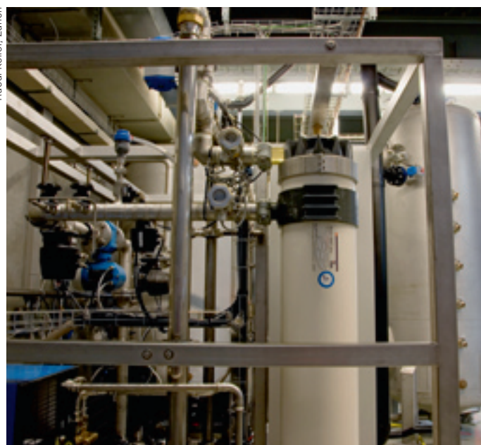
Module membranaire du pilote étudié à l'usine de production d'eau potable de Lengg.
