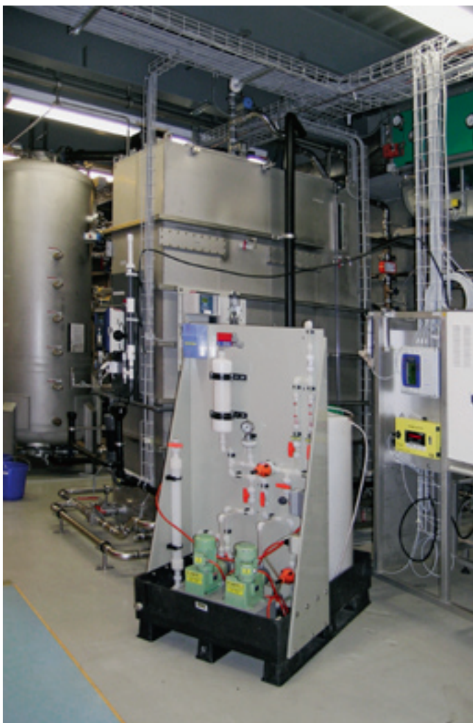
Station pilote de potabilisation de l'eau du lac de Zurich à l'usine de Lengg.
