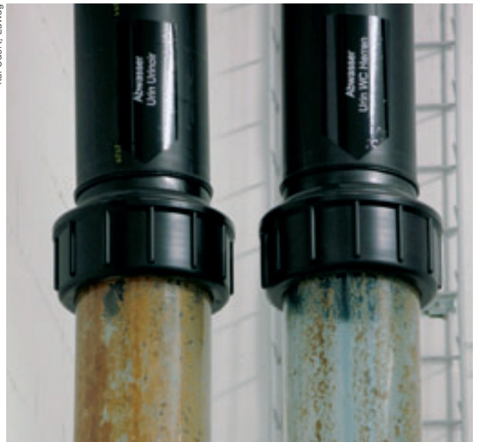
Vertikal geführte Urinleitungen mit grossem Durchmesser verhindern Verstopfungen.
