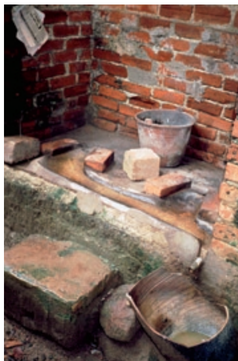
Zweikammer-Latrine mit Urinseparierung (Vietnam). Latrinboden mit zwei Löchern zu den beiden Kammern, Rinne für die Urinableitung und Urinbehälter.
