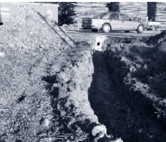
Abb. 3: Anschluss der Versuchsanlage an das Strassenabwasser
