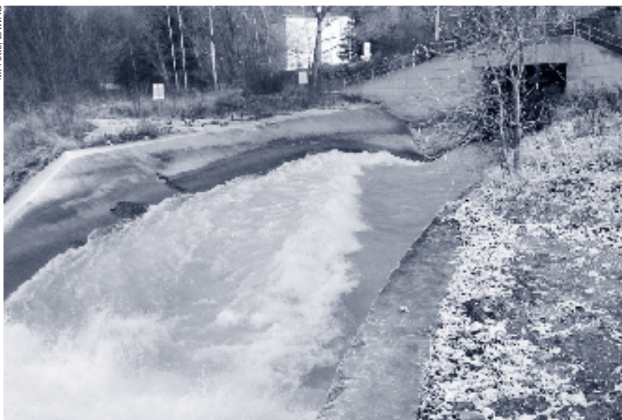
Schwallwellen werden durch die Rückgabe von Turbinenwässern erzeugt.
