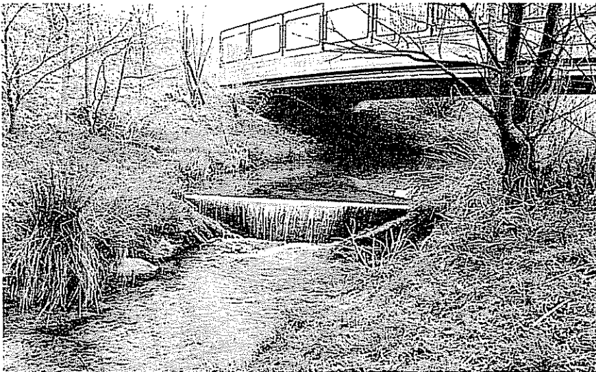
Fig. 2 Durchgängigkeitsstörung am Sagentobelbach, etwa 400 m oberhalb der Mündung in die Glatt. Von der Mündung aus gesehen ist der 40 cm hohe Absturz die erste künstliche Durchgängigkeitsstörung, denn dadurch können sich 7 Fischarten nicht mehr bachaufwärts ausbreiten.
